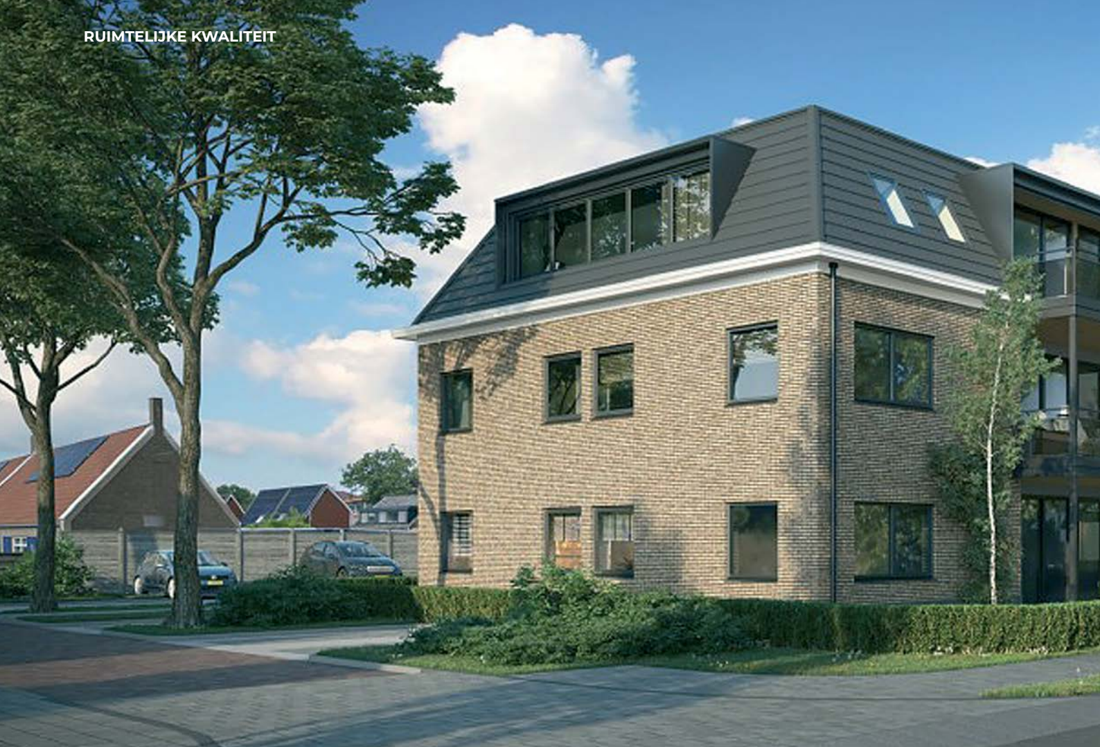
BOPA: transformatie politiebureau naar woongebouw.
