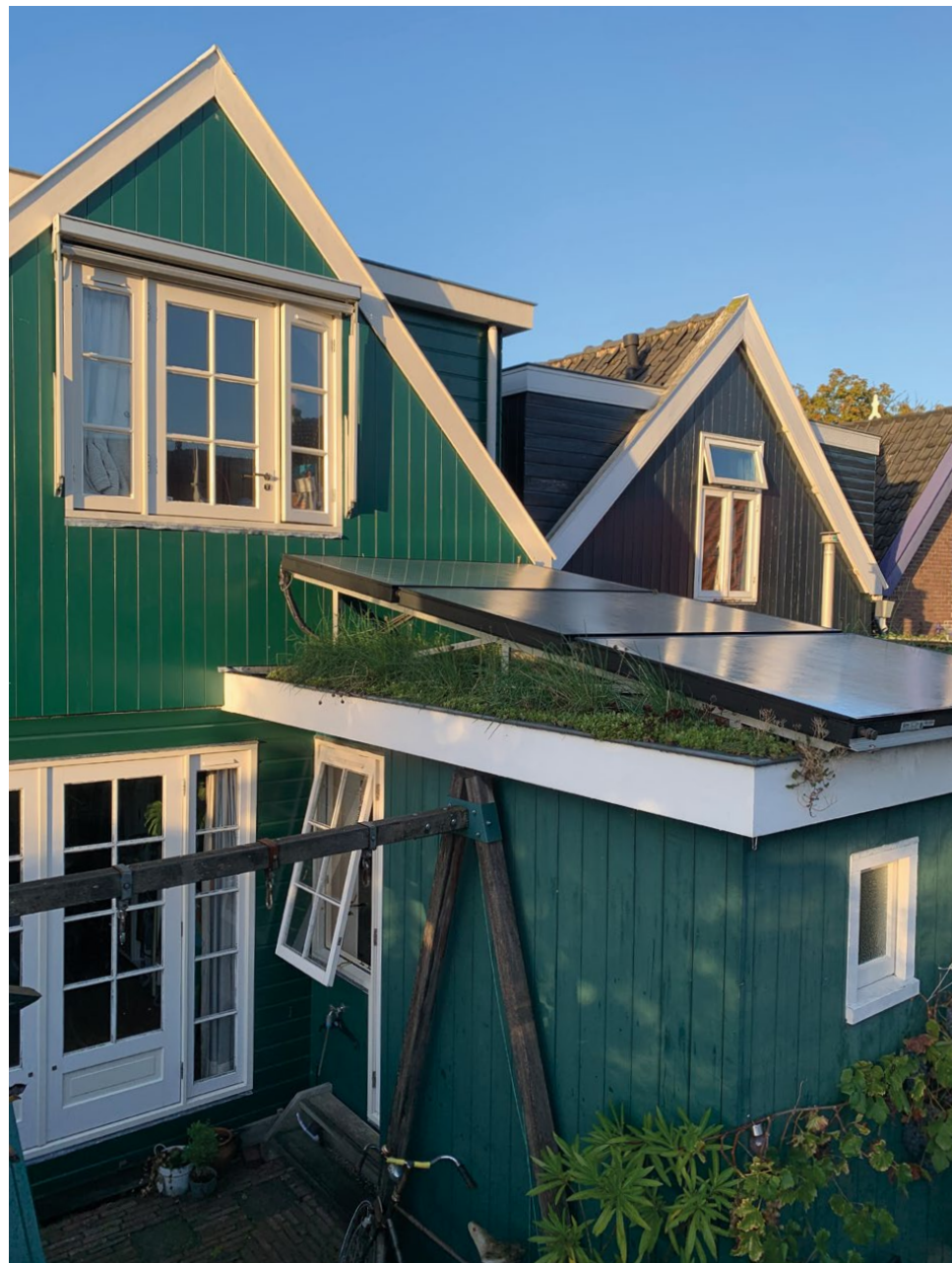
Warmtecollectoren op het bijgebouw t.b.v. warmteboiler.
