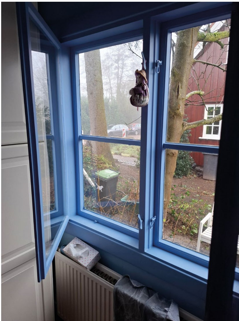
Origineel binnen- en buitenraam Noorse woning, binnenzijde..
