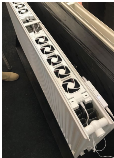
Radiatorventilator bovenzijde radiator. Bron: www.installatie.nl
