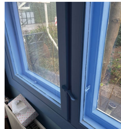
Origineel binnen- en buitenraam Noorse woning.
