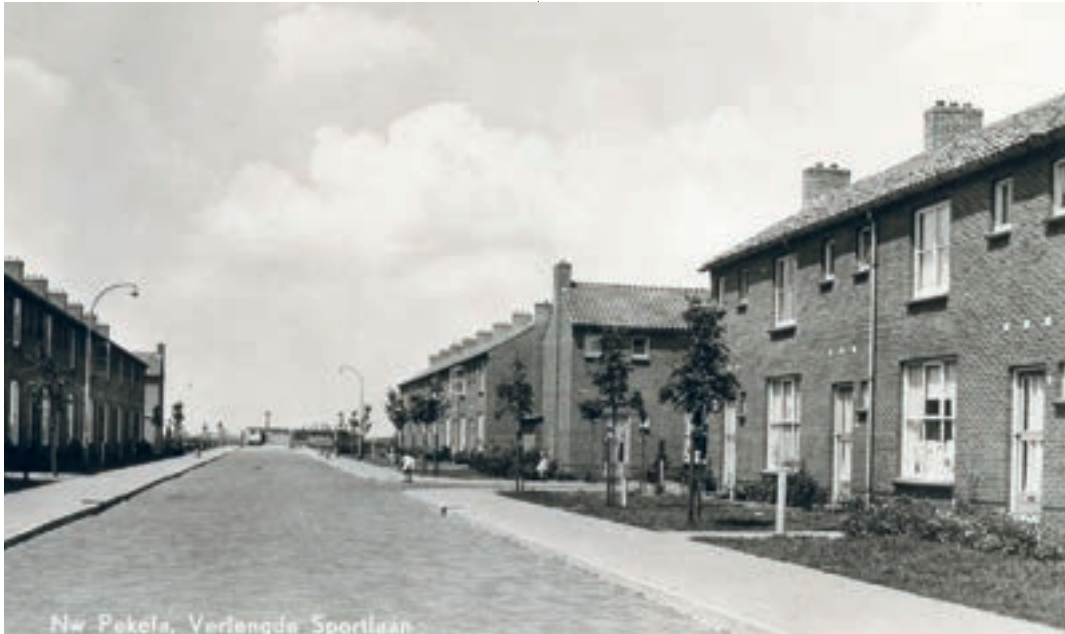
Woningen uit het 1000-woningenplan in Nieuwe Pekela
