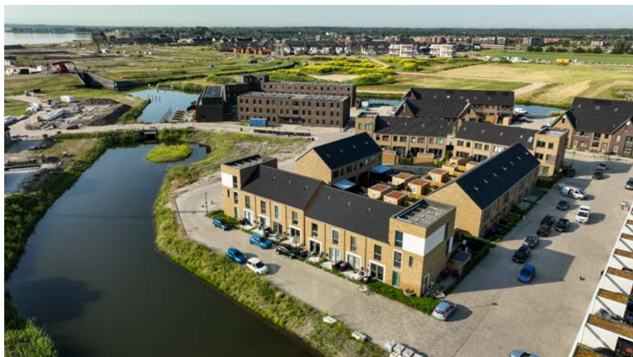
Foto: Heijmans Horizon woningen in Zeewolde.
