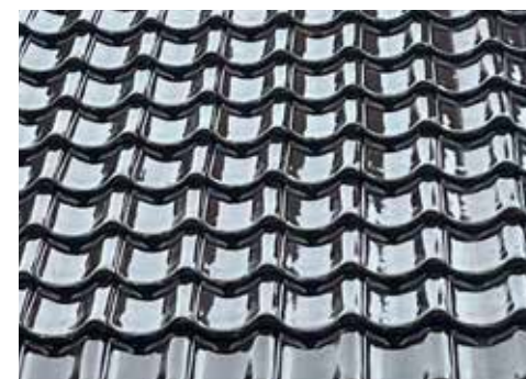
bruin geglaazuurde dakpannen
