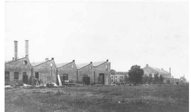
Appingedam, Brons motorenfabriek met lessenaarsdaken
