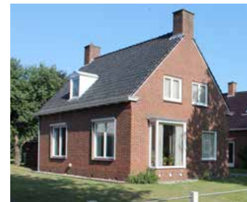
erker, dakkapel en bakgoot op klossen
