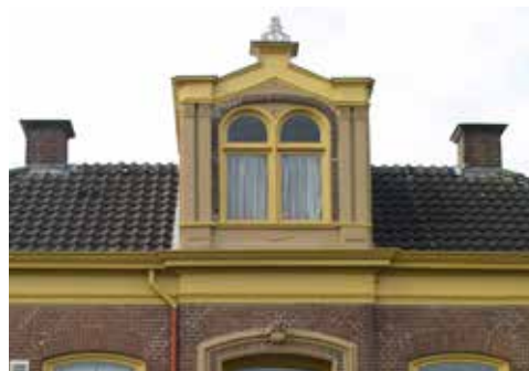
lijstgoot met uitvoerige dakopbouw
