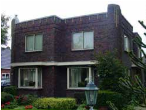
tweelaags met een plat dak
