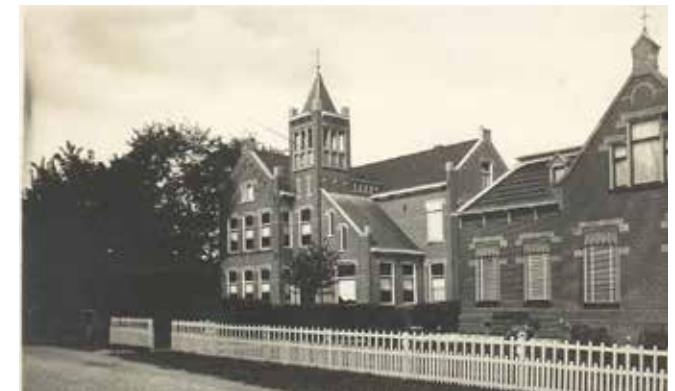
Ten Boer, samengesteld gebouw met torentje
