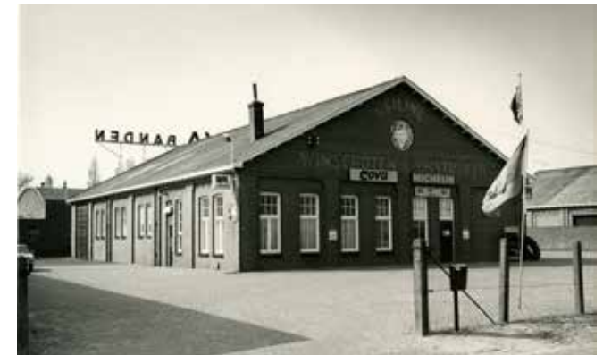
Winschoten, voormalig veilinggebouw gebruikt als opslag
