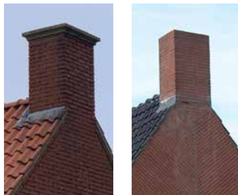
topgevel zonder en met boerenvlechtwerk
