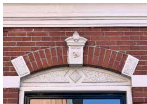
getoogde rollaag met sluitstenen
