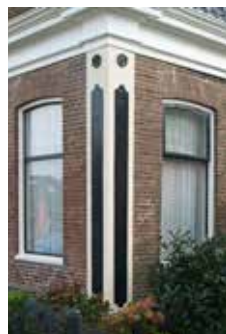
pilaster op de hoek
