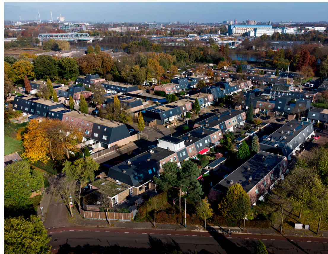
Proeftuinwijk met laagbouw in het Nijmeegse stadsdeel Dukenburg. Gemeente Nijmegen wil samen met Firan en het Innovatie- en Energiefonds Gelderland een warmtenet aanleggen naar stadsdeel Dukenburg.
