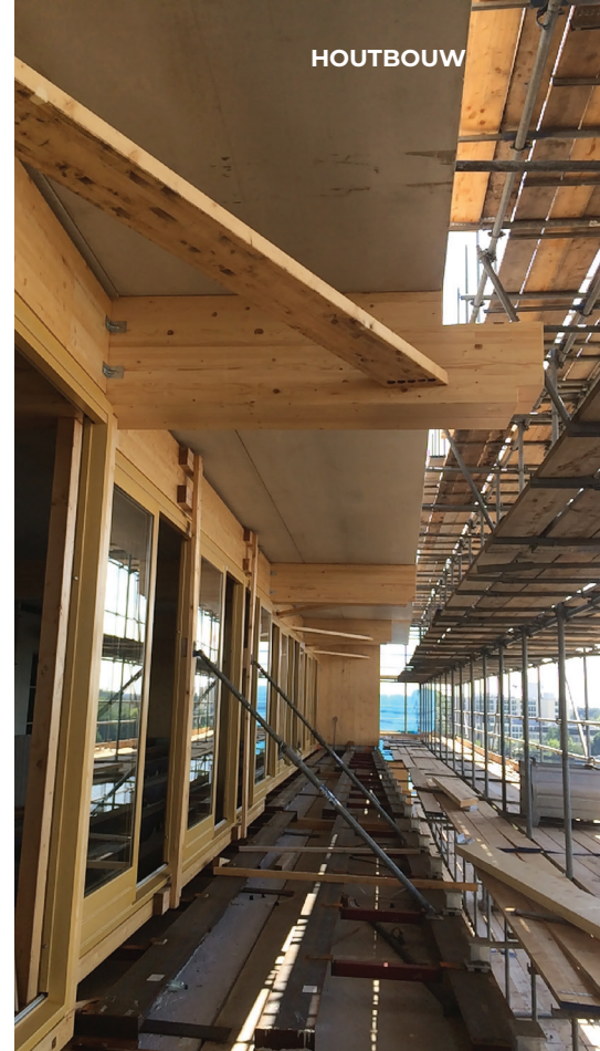
Patch22 heeft dragende CLT-buitenwanden en kolommen en balken van Gluelam
