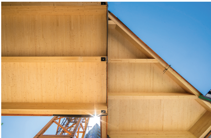
HAUT heeft een hybride houtconstructie, beton en CLT.
