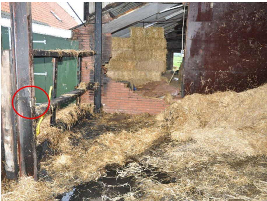
Figuur 2.2 Als gevolg van laswerkzaamheden zijn stobalen tot ontbranding gekomen (Bron: Team brandonderzoek Gelderland-Midden)
