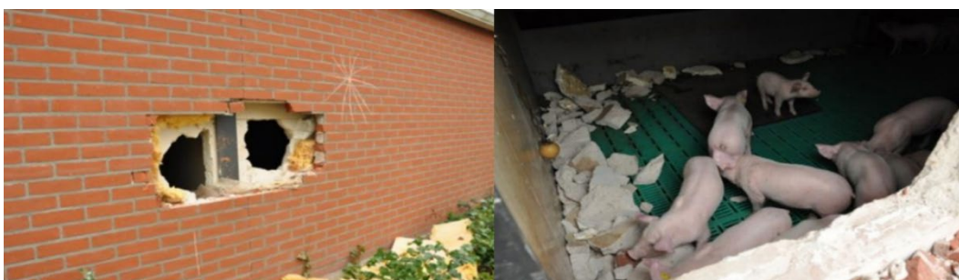
Figuur 3.6 Door de brandweer gemaakte nood ventilatieopeningen in een varkensstal (Bron: Brandweer Brabant Zuid-Oost)
