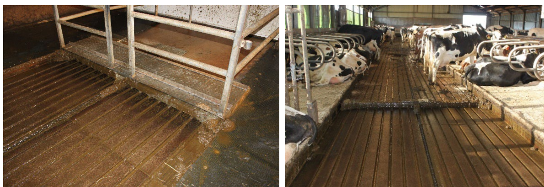
Figuur 2.27 Dichte vloer met mestschuif en afstortplaats naar mestkelder onder de dichte vloer (Bron: Brandweeracademie)
