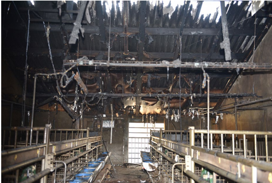
Figuur 2.7 Isolatiemateriaal op basis van aardolie in een kalverenstal (Bron: Team brandonderzoek Gelderland-Midden)
