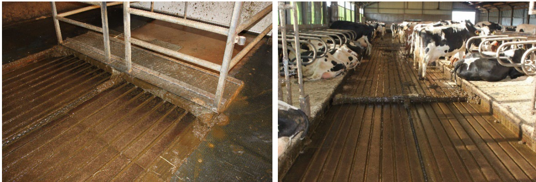
Figuur 2.27 Dichte vloer met mestschuif en afstortplaats naar mestkelder onder de dichte vloer (Bron: Brandweeracademie)
