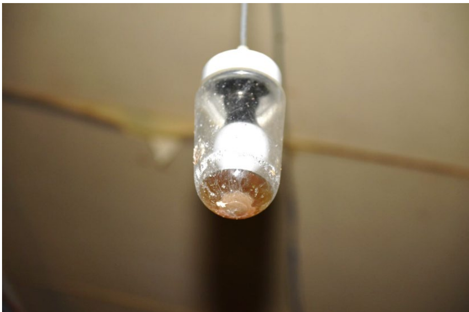
Figuur 2.31 Water in de verlichtingsarmaturen van een leghennenstal (Bron: Team brandonderzoek brandweer Gelderland-Midden)
