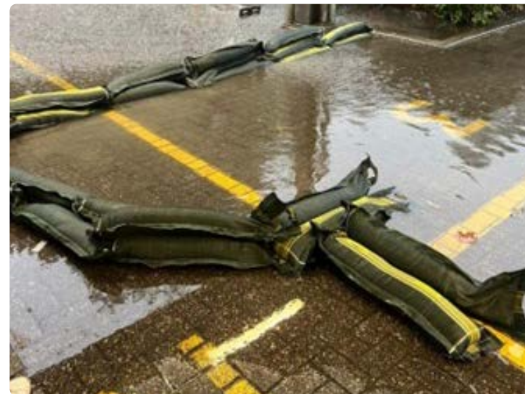
Figuur 18: Geplaatste zandzakken (bron: Slingeland.nl).
