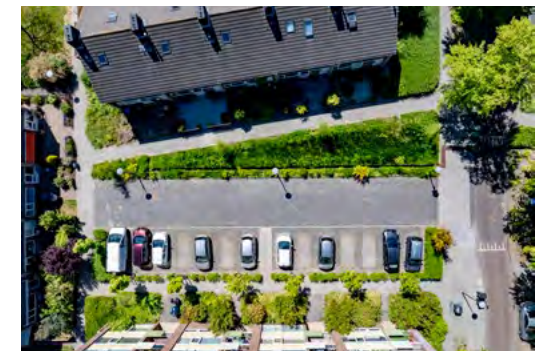
Versteende hofjes maken plaats voor parkeren met infiltratie, groene, bloeiende wadi's en een robuust systeem van afvoergoten.
