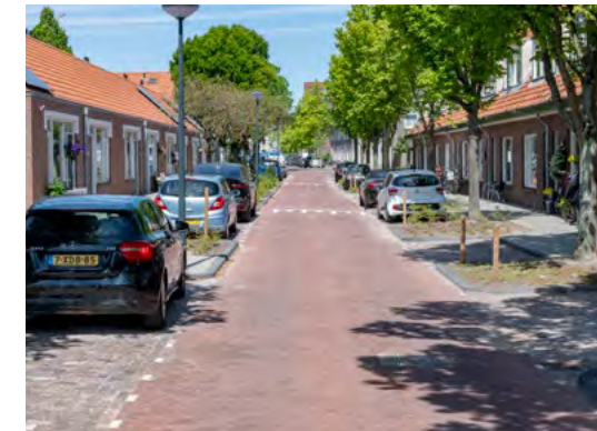
In de nieuwe situatie zijn veel nieuwe groenborders met diverse planten toegevoegd. Ook hier heeft de wijk nu gescheiden riolering.
