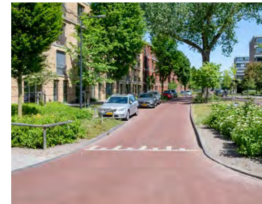
De nieuwe inrichting geeft ruimte aan parkeren en diversiteit in groen. Ook is een drainagesysteem toegepast om het grondwater te reguleren in dit kleiige gebied.
