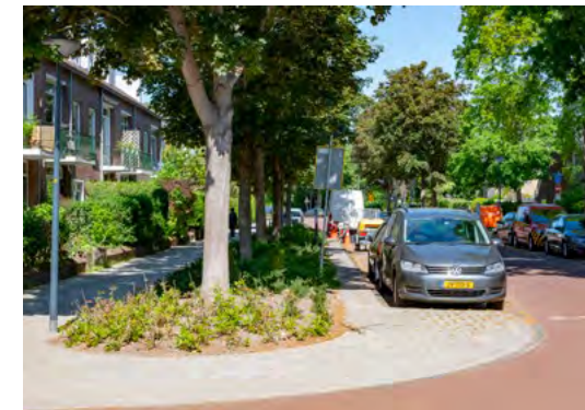
De nieuwe inrichting geeft ruimte aan parkeren en diversiteit in groen. Ook is een drainagesysteem toegepast om het grondwater te reguleren in dit kleiige gebied.
