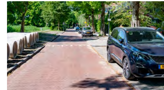
De weg is versmald en heeft langspaarplaatsen met het 'kruisverband' als open verharding. Regenwater wordt apart verzameld en naar de watergang geleid.
