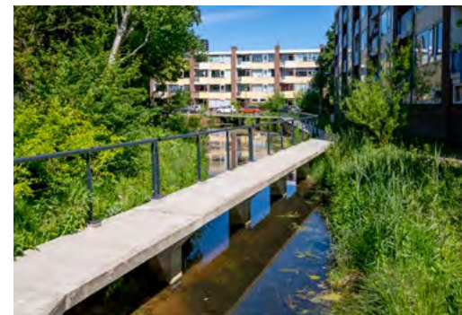
Door de klassieke grasvelden in te richten als waterbuffer, met speelse looppaden over het water, groeit de beleefbaarheid enorm.
