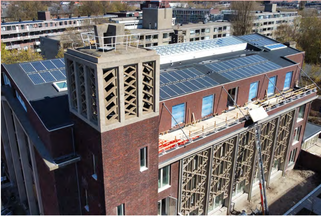
De Pauluskerk tijdens de verbouwing naar appartementen, Den Haag - Afbeelding: giesbersrotterdam.nl
