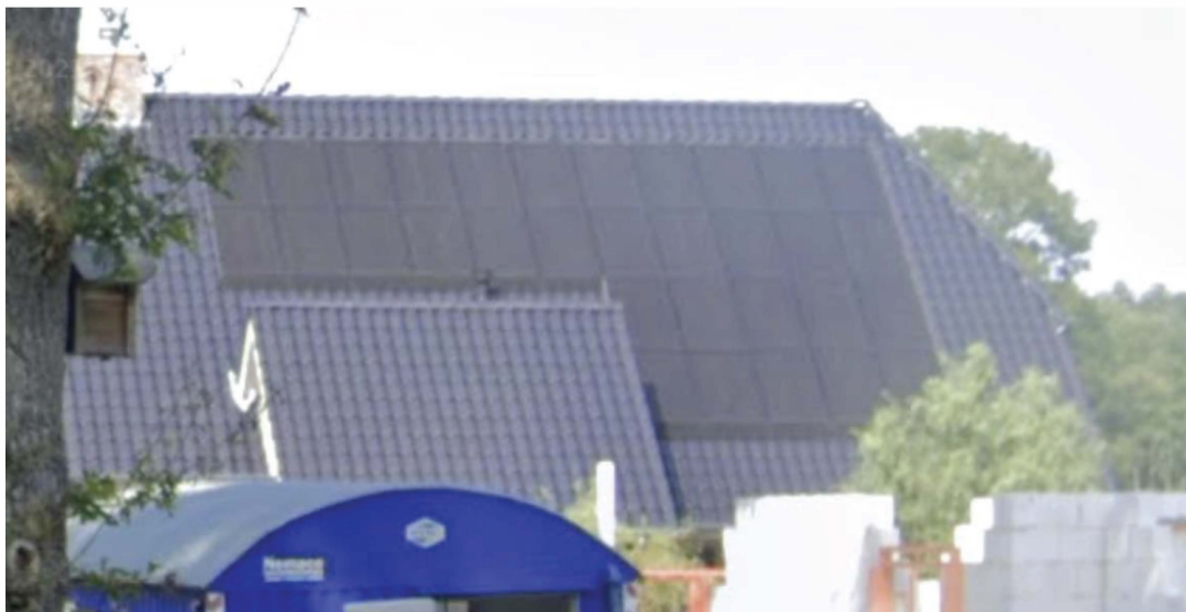
Figuur 11: Voorbeeld dak van één van de brandlocaties voor de brand. Google Streetview 2021
