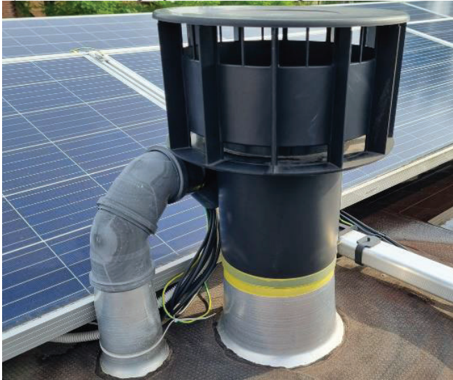
Figuur 10: Voorbeeld van een uitlaatpijp die te dicht op de panelen is geplaatst en daardoor de bypass diode langdurig in geleiding zet met warmteontwikkeling tot gevolg.
