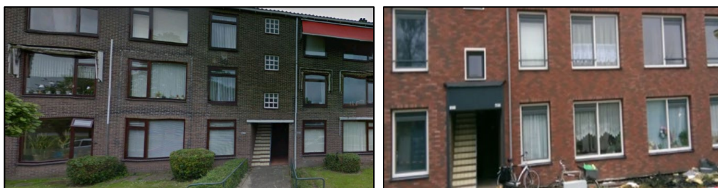
Figuur 3.1 Woningcomplex voor (links) en na (rechts) verduurzaming. De woningen zijn voorzien van gevelisolatie, dakisolatie, zonnepanelen en nieuw glas. Het enige wat herkenbaar is, is de trap die toegang geeft tot de boven gelegen woningen (Bron: Goos Janssen)
