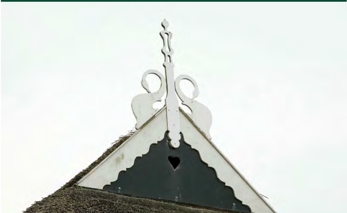
Een uilenbord diende voor ventilatie en ter bescherming tegen inwatering. Door het gat kunnen kerk- en steenuilen in- en uitvliegen (2007).
