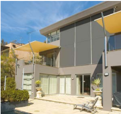
Voorkom oververhitting door het toepassen van diepe overstekken, buitenzonwering, luifels of luiken.
