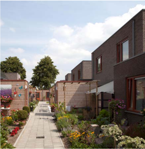
ERA Contour heeft in opdracht van Stadlander 34 energieneutrale nultredewoningen gebouwd in Steenberg.
