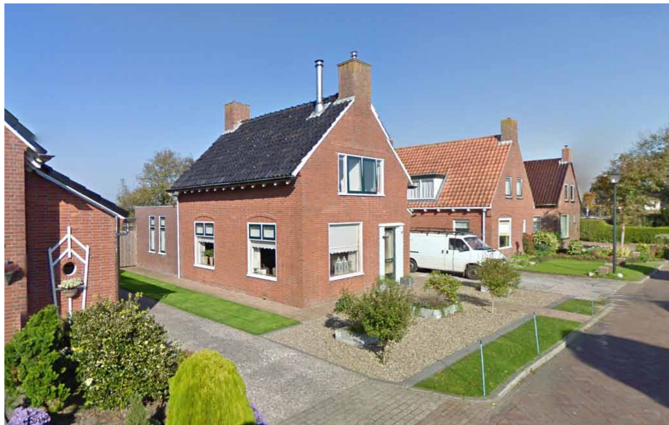
De burgerwoning in zijn huidige toestand opgetrokken uit metselwerk.
