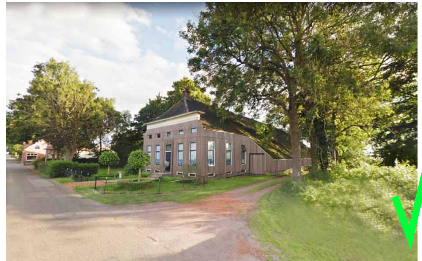
De boerderijwoning in zijn bestaande situatie is hier bekleed met hout.
