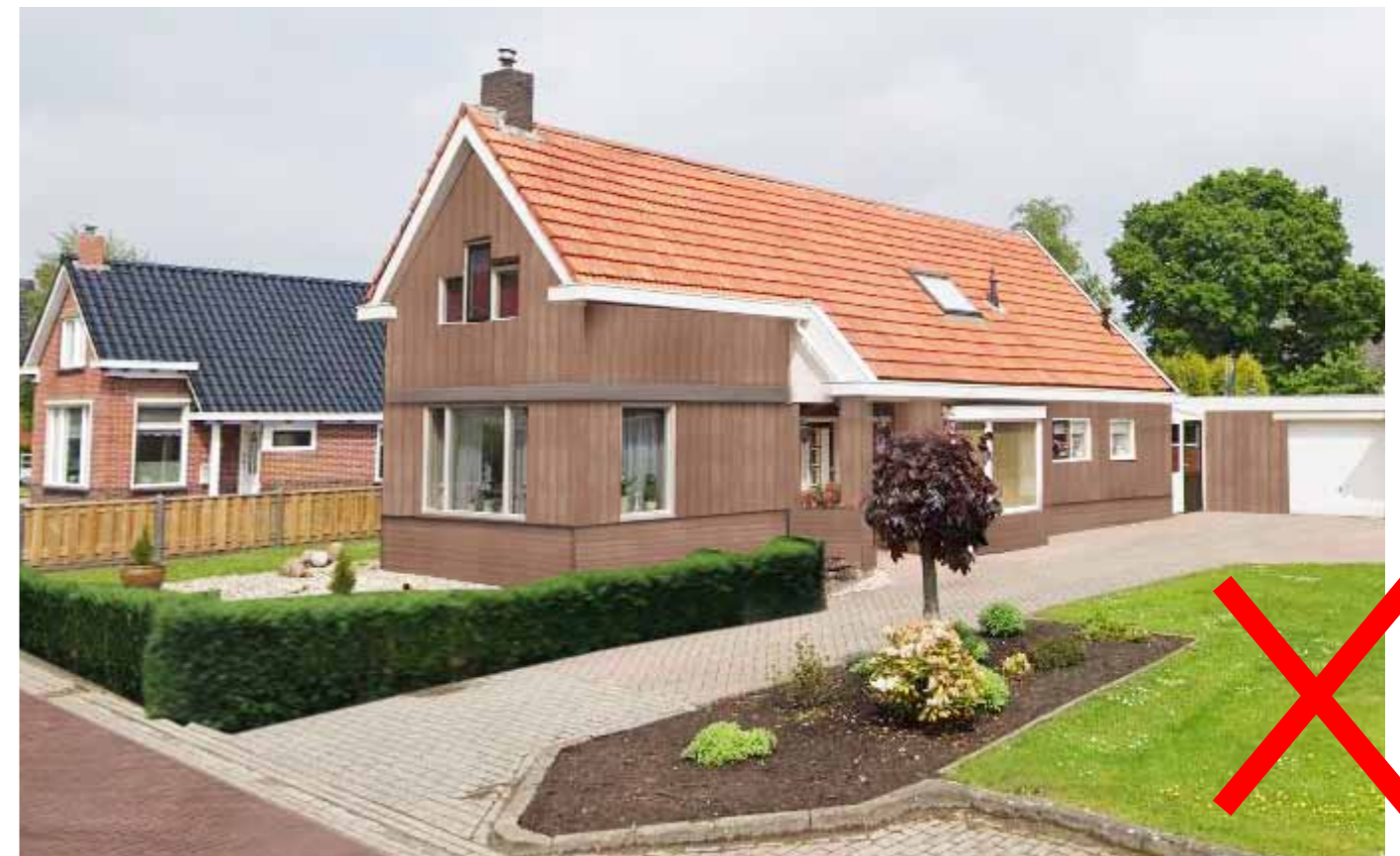
Het krimpenhuis in zijn bestaande situatie is hier bekleed met hout. De typische hout kenmerken ontbreken hier waardoor het een niet eerlijk beeld opleverd.
