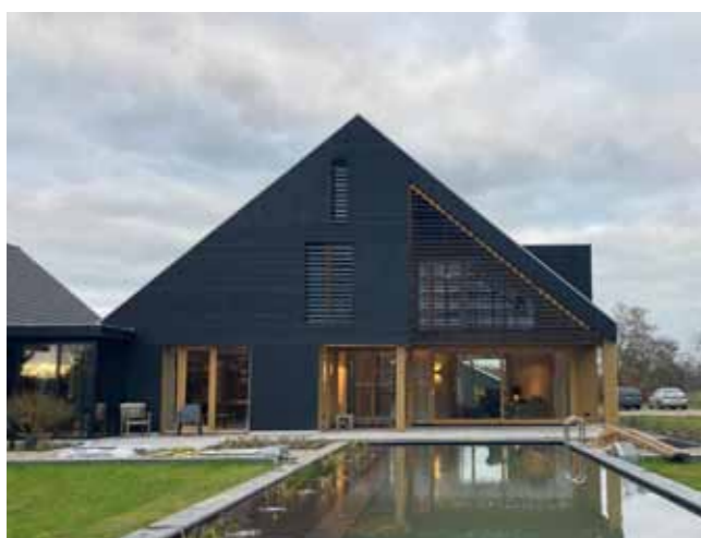
Bij de schuurwoning is de constructie zichtbaar.
