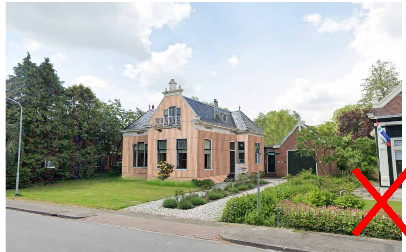
De villa in zijn bestaande situatie is hier bekleed met hout. De typische hout kenmerken ontbreken hier waardoor het een niet eerlijk beeld opleverd.
