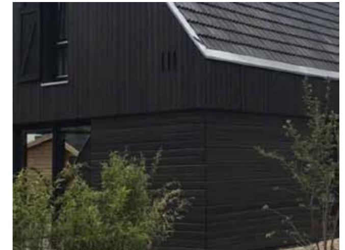
De verdieping kraagt iets uit. Het hout is behandeld.
