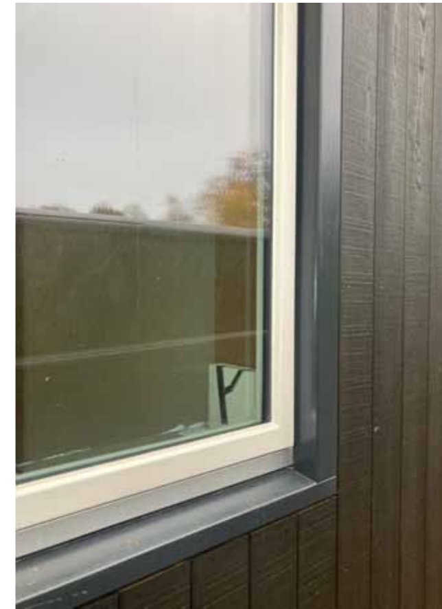
Het kozijn ligt vlak in de gevel.
