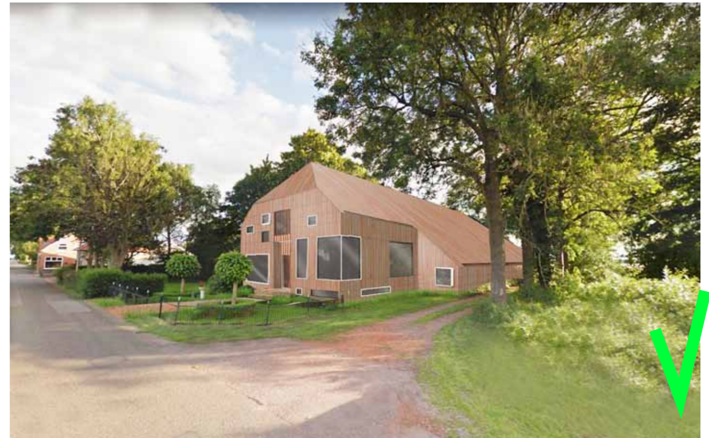
In dit beeld is de typologie geabstraheerd door het dak uit te voeren in hout, het overstek en de schoorstenen weg te laten en de symmetrie los te laten. Typische houtkenmerken zijn de meer horizontaal georiënteerde raamopeningen, opleggende en in het gevelvlak liggende kozijnen en het hoekraam.
