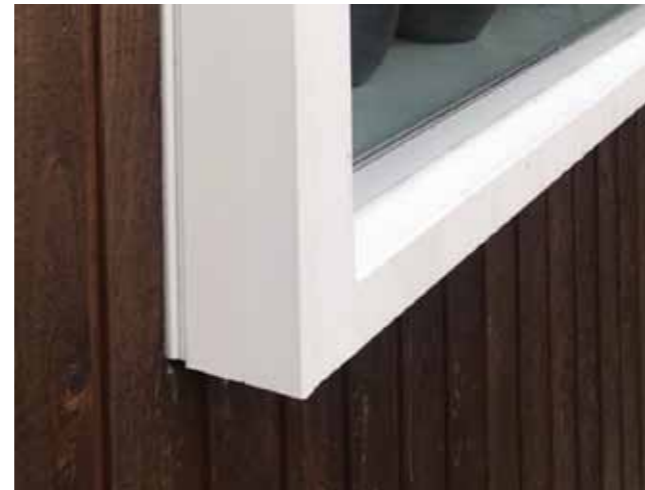
Het kozijn ligt op de gevel.
