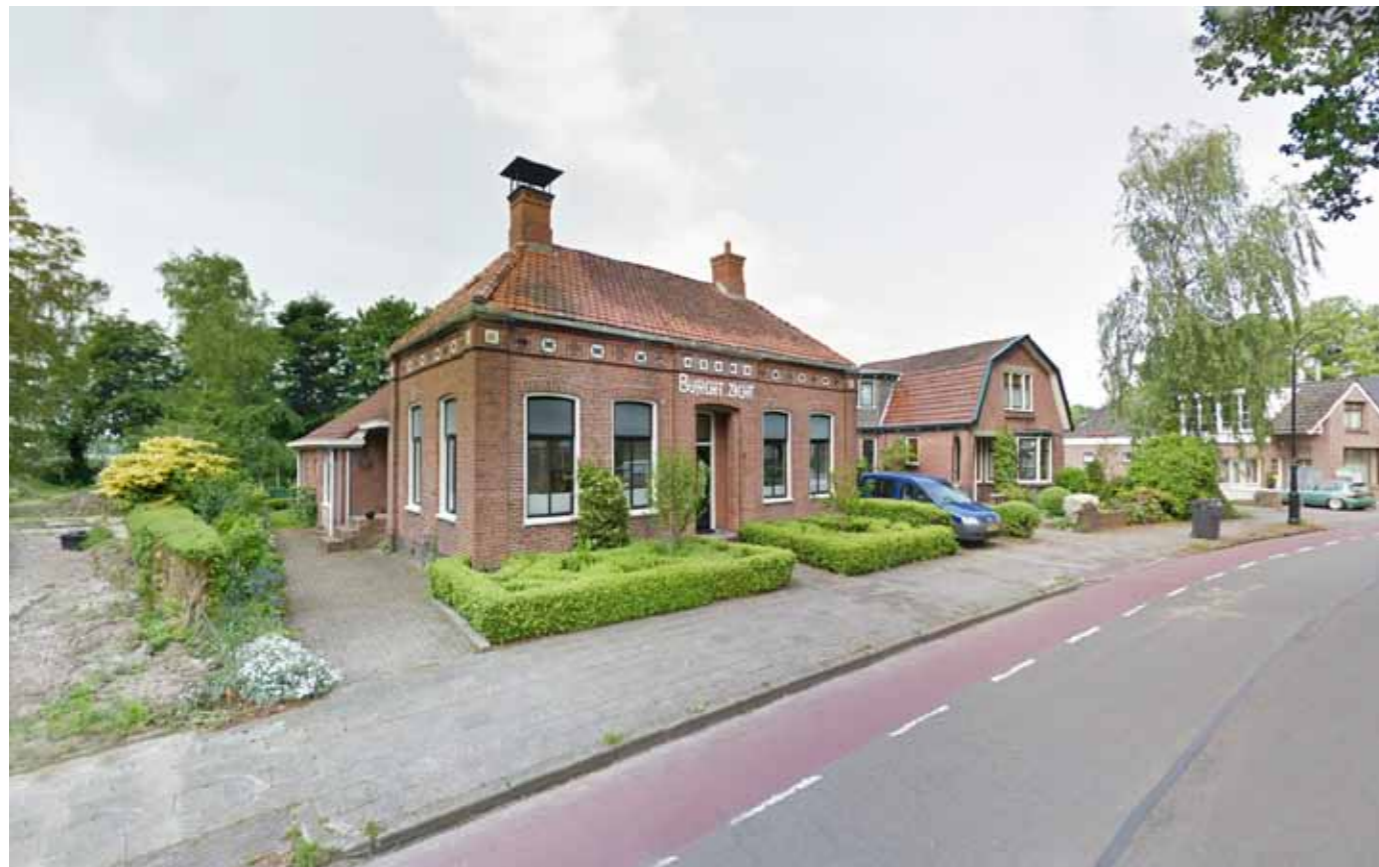
Het dwarshuis in zijn huidige toestand opgetrokken uit metselwerk.
