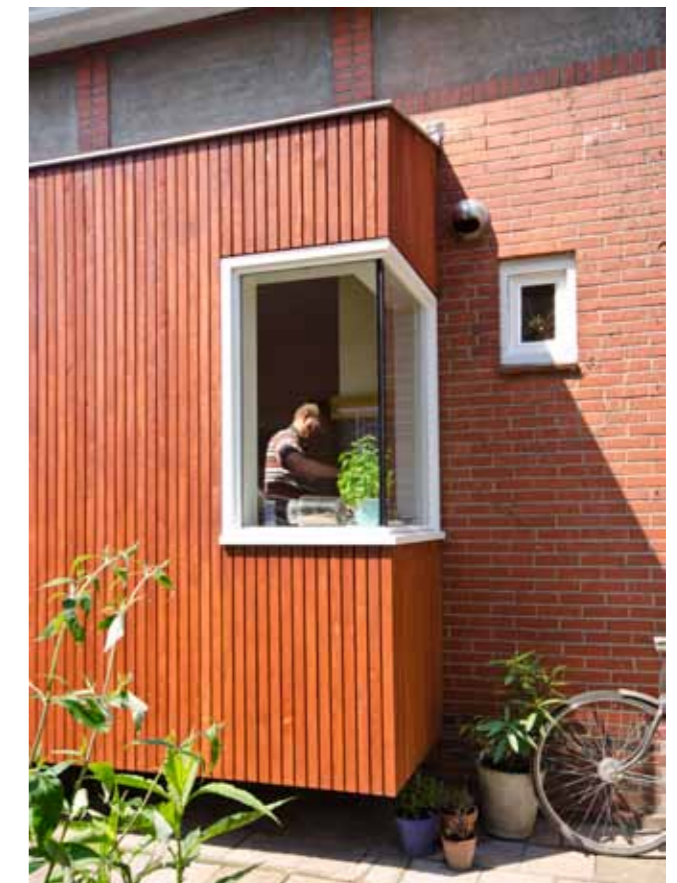
Grote horizontale ramen en hoekramen zonder stijl zijn goed mogelijk met houtbouw.
