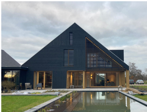
Bij de schuurwoning is de constructie zichtbaar.
