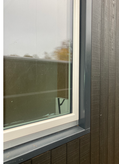
Het kozijn ligt vlak in de gevel.
