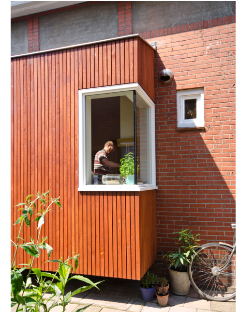
Grote horizontale ramen en hoekramen zonder stijl zijn goed mogelijk met houtbouw.
