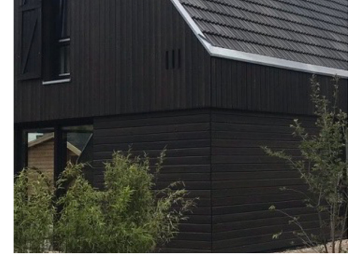
De verdieping kraagt iets uit. Het hout is behandeld.
