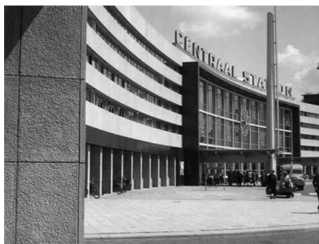
7. Modernistische Stations: Rotterdam
